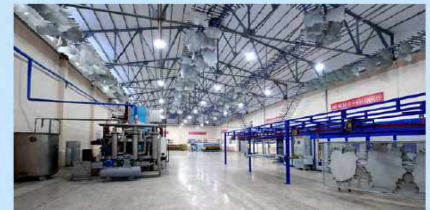
Fábrica Curtidora de Pyongyang modernizada
